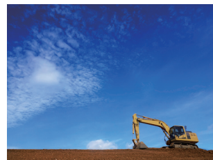
土木工事・測量
