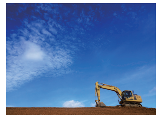
土木工事・測量
